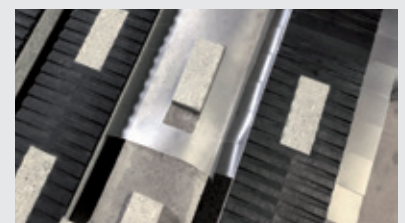
Nachträglicher Einbau der Emissionsklappen
